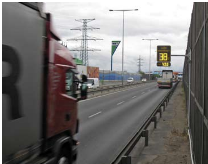
Ukázka instalace systému rozšířeného o proměnnou dopravní značku s aktuální změřenou hmotností a hmotnostním limitem
